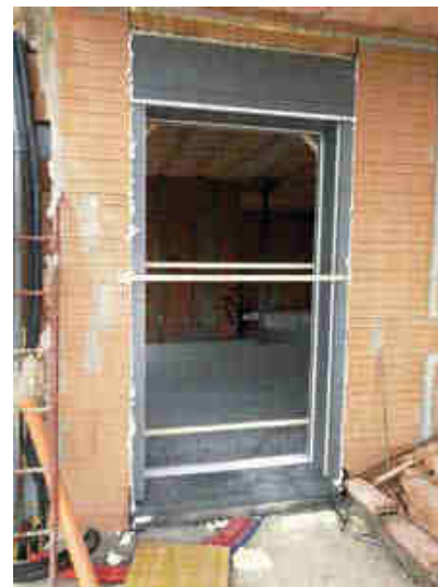
Controtelaio Magò in cantiere
